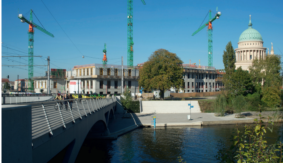
Blick auf die Baustelle des neuen Landtagsgebäudes.
