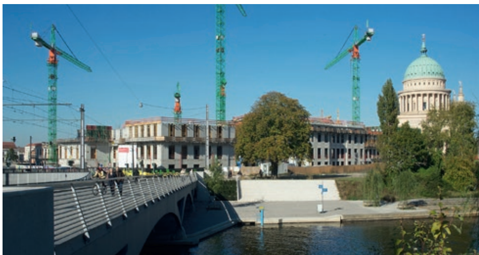
Blick auf die Baustelle des Landtagsgebäudes
